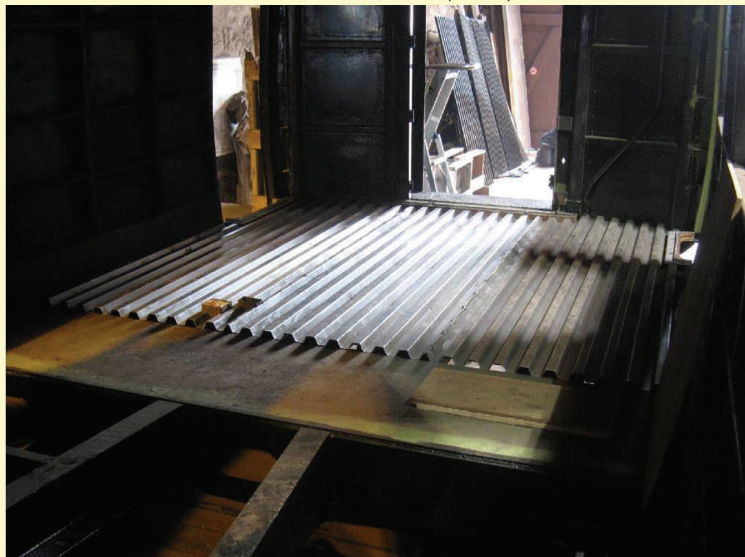
New sheeting inside Sc79943, 13/7/12 (J.Horne)
